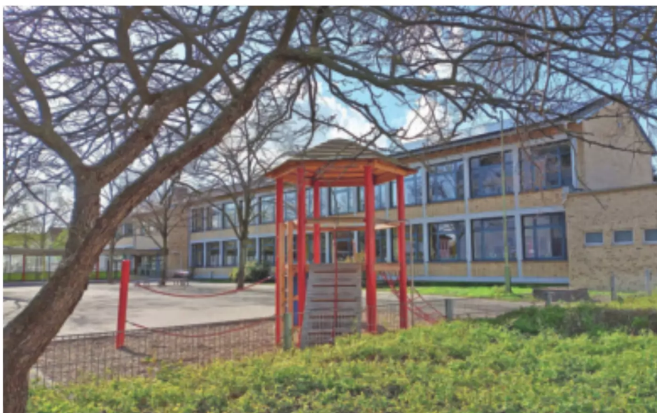
Das Schulgebäude der GGs Rahser an ihrem Hauptstandort Regentenstraße.
